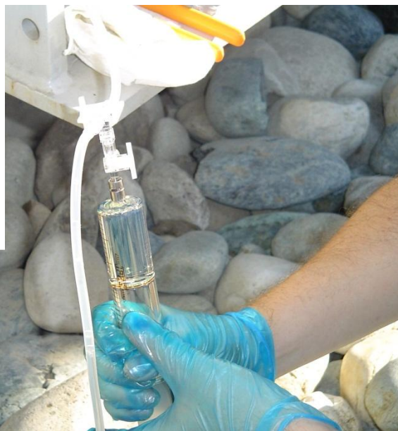
Fluido del Trasformatore
