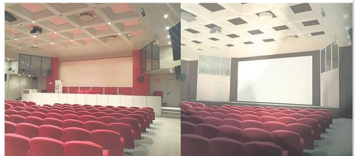
Il Centro congressi prima dei lavori e, a destra, il render del risultato finale
